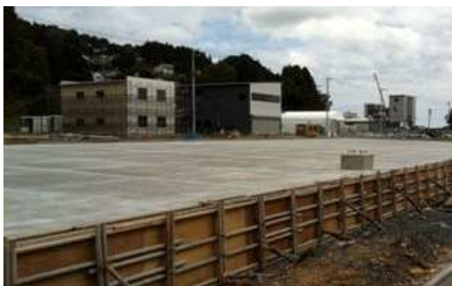
仮設魚市場の工事風景 (9月25日現在)
