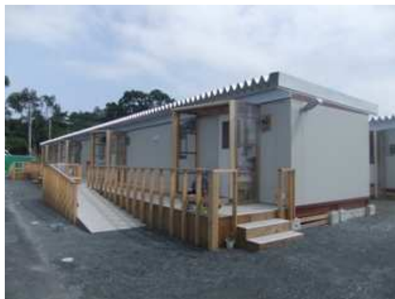
山元町福祉施設外観 (玄関が広くひさしも大きい)
