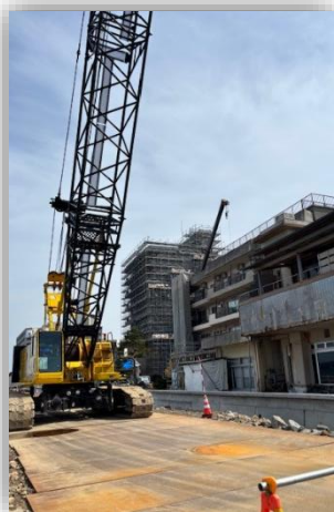
和倉温泉 護岸復旧工事中
