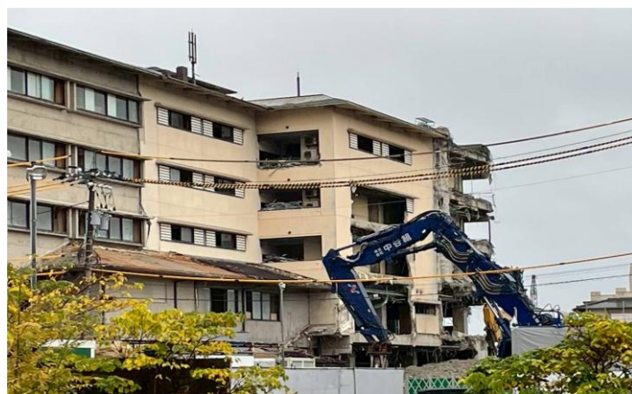
解体が進む旅館 和倉温泉
