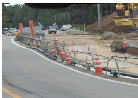
工事が続く送迎道路
