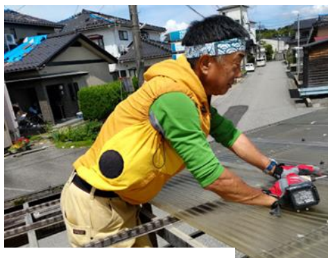
ガレージの波板撤去の作業
