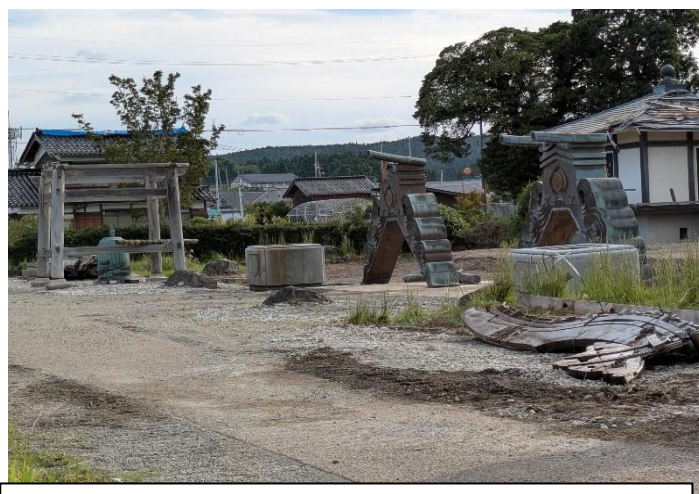
解体が進む珠洲市妙厳寺
