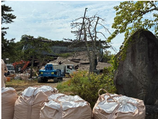
珠洲市妙厳寺 いよいよ解体が始まりました。
