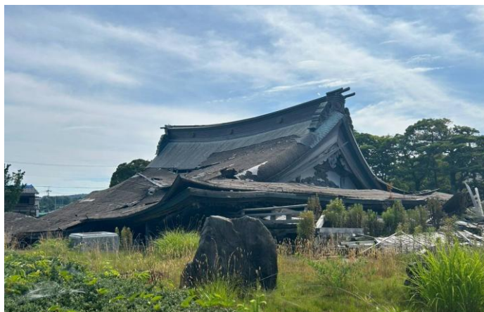
珠洲市妙厳寺 7月末から解体が始まります。
