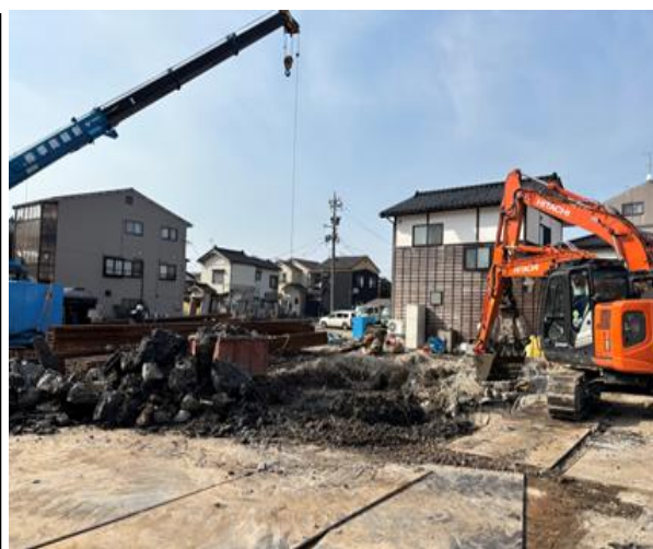
解体が進む輪島の倒壊ビル
