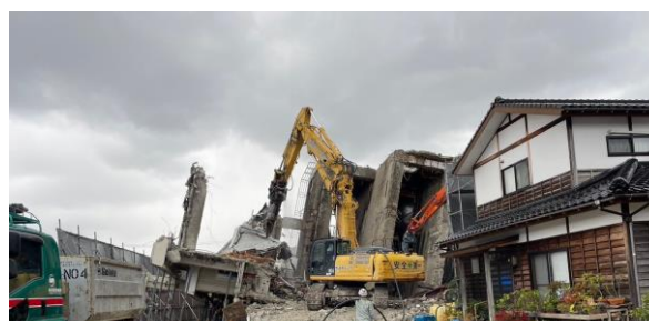
解体が進む輪島のビル
