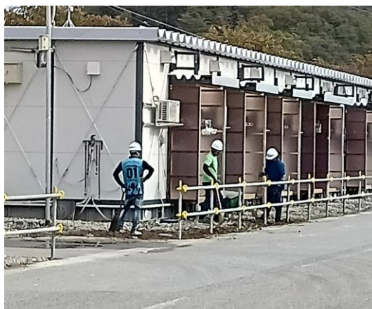
輪島の仮設住宅
