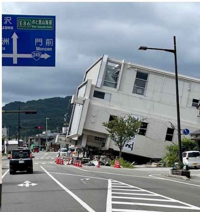
▲倒壊して今なおそのままのビル(輪島市)
