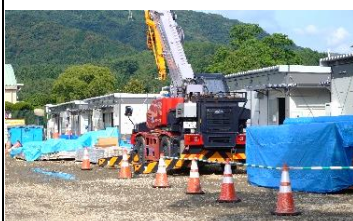
益城町飯野小学校グラウンドの仮設住宅建設現場
